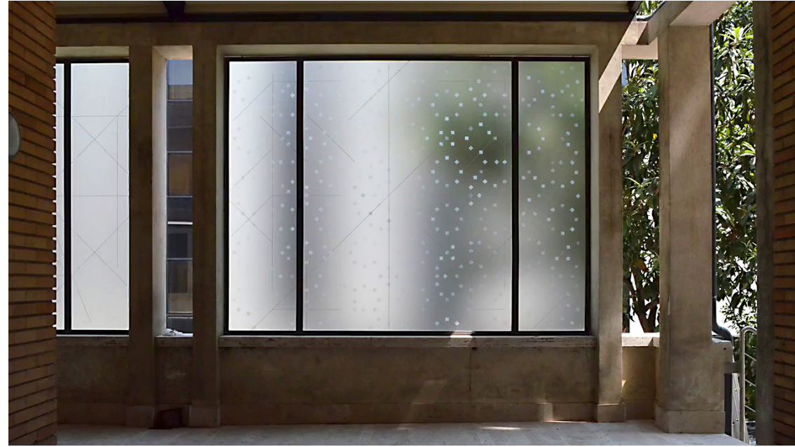
Window / fenêtre n°5
